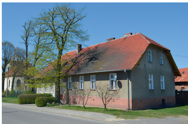
Budynek szkoły, stan z 2015 roku
